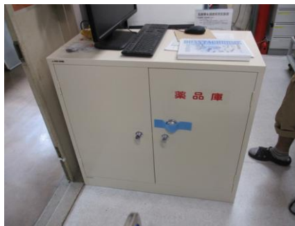
薬品庫の耐震固定
